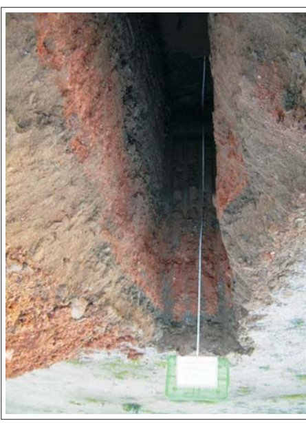
Foto 26: Cala C-5 excavada.
