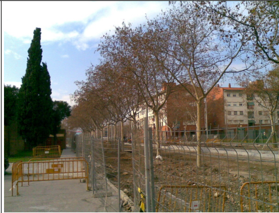
Fotografia 20: Obres al carrer Llobregat
