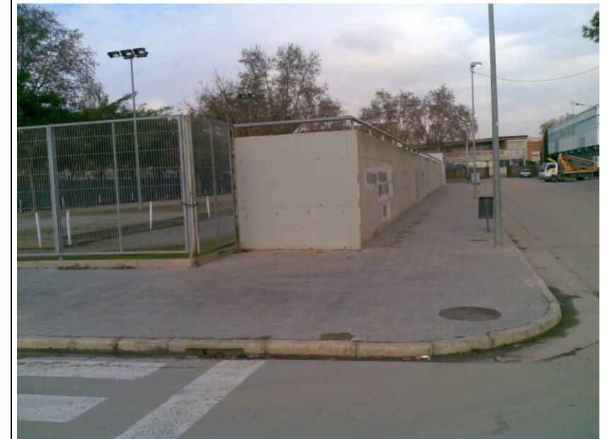
Fotografia 3: Instal·lacions de petanca a ederrocar.
