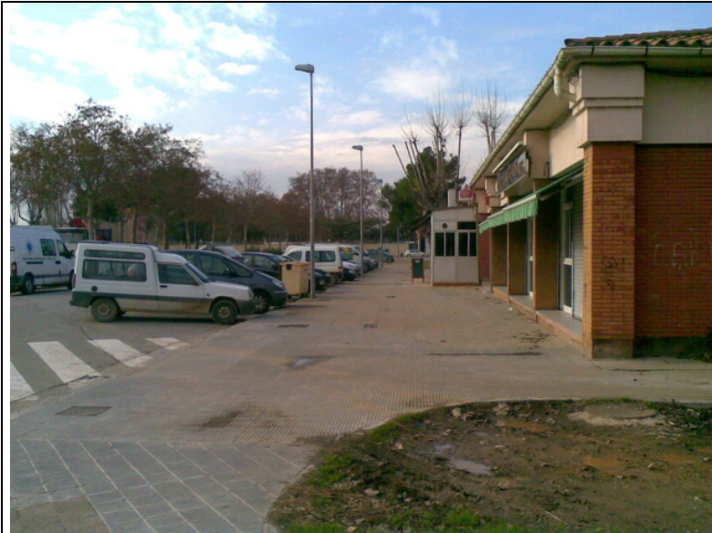
Fotografia 13: Edificis a enderrocar
