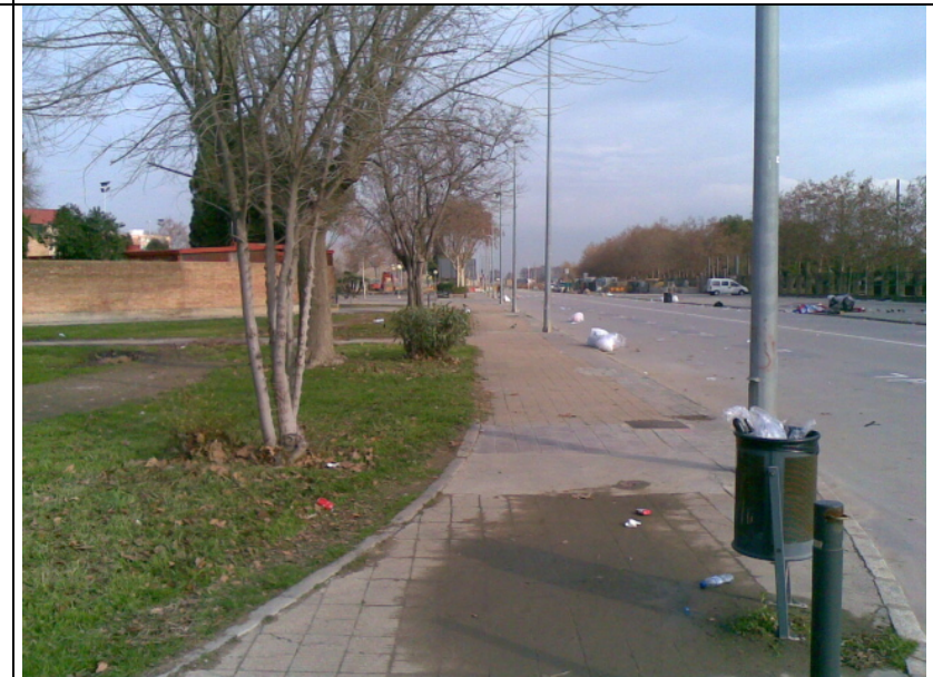
Fotografia 12: Paviments de peces de formigó sobre morter en vorera Ronda Sud a enderrocar. Punts de llum i papereres a eliminar.
