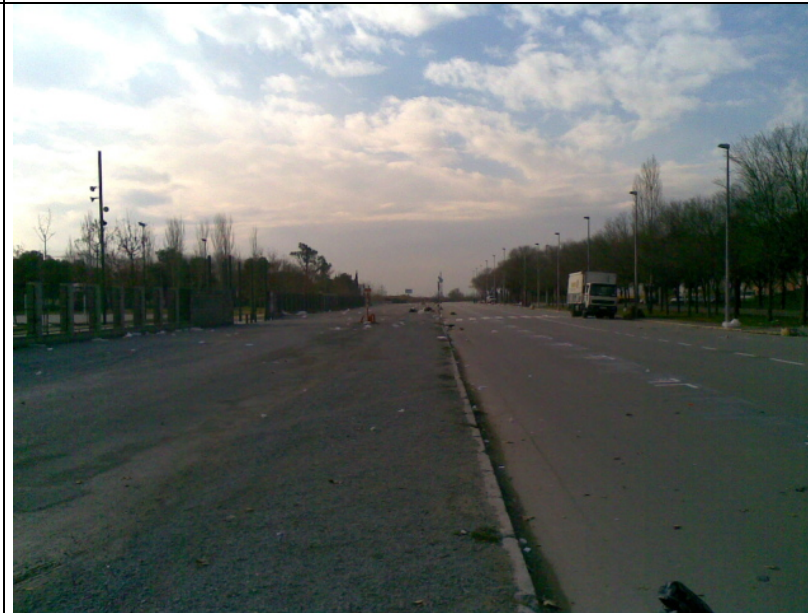
Fotografia 5: Ronda Sud. Futur carril bici per sobre del traçat de l'oleoducte de CLH.
