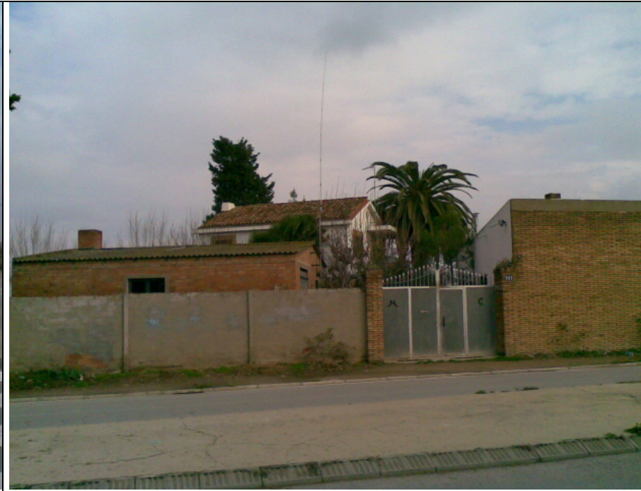
Fotografia 26: Edificis a enderrocar a la cruïlla Av. Remolar-ctra. Aviació.
