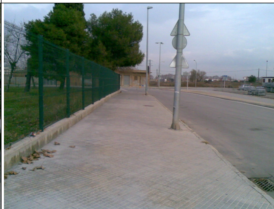
Fotografia 23: Tancament camp de futbol (banda Ronda Sud) a enderrocar.
