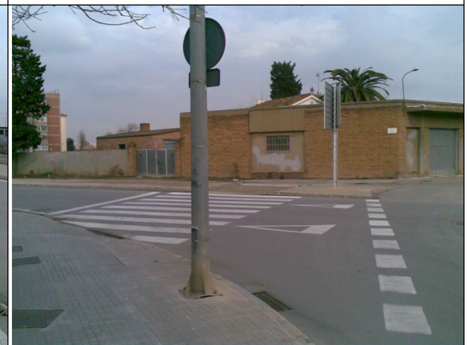
Fotografia 24: Paviment avinguda remolar on se li aplicarà una rodadura amb mescla betuminosa tipus D-12. Edificis del fons a enderrocar.
