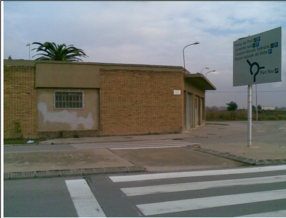
Fotografia 25: Mitjana Avinguda Remolar a enderrocar i a reconstruir. Edificis cruïlla Av. Remolar-ctra. Aviació a enderrocar.
