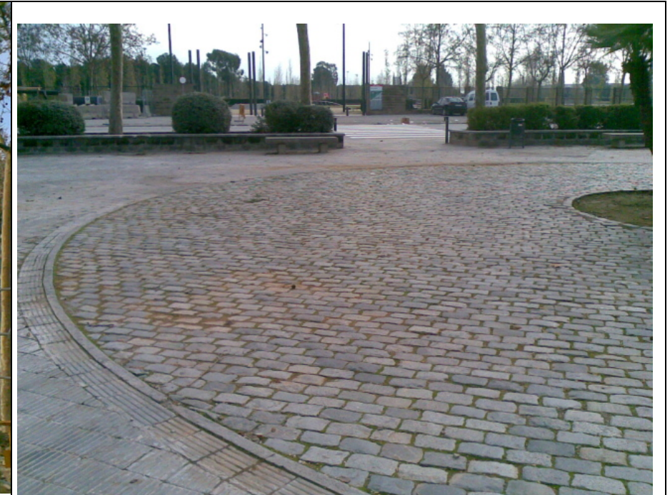
Fotografia 21: Paviment de llamborda granítica a enderrocar i aplegar material per a posterior col·locació al botó central de la nova rotonda de la Ronda Sud.
