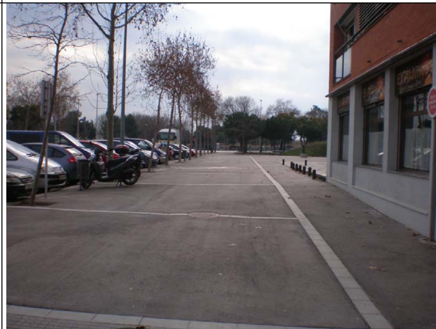
Fotografia 35: c/Riu Xúquer. Paviment asfàltic de vorera a enderrocar.
