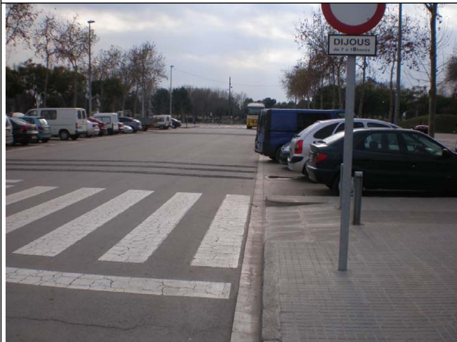
Fotografia 34: c/Riu Xúquer. Paviment asfàltic a enderrocar.
