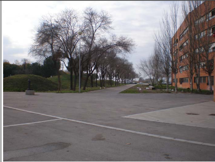
Fotografia 8: Ronda Sud. Motes d'enjardinament a excavar per deixar la superfície regular. La superfície de paviment asfàltic existent s'enderrocarà.
